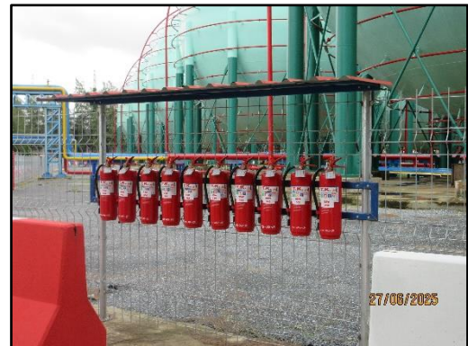
รูปที่ 40 ถังดับเพลิงเคมี บริเวณถังเก็บก๊าซปิโตรเลียมเหลว
