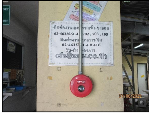
รูปที่ 33 อุปกรณ์แจ้งเหตุด้วยมือ
