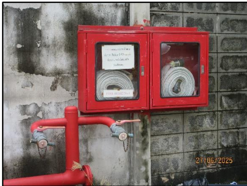
รูปที่ 43 (ต่อ) ระบบดับเพลิงแบบ Fire Hose ภายในพื้นที่โครงการ
