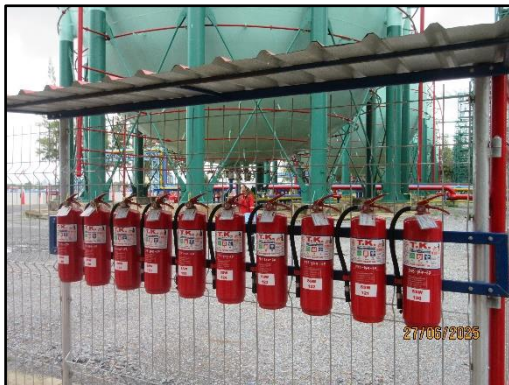
รูปที่ 40 ถังดับเพลิงเคมี บริเวณถังเก็บก๊าซปิโตรเลียมเหลว
