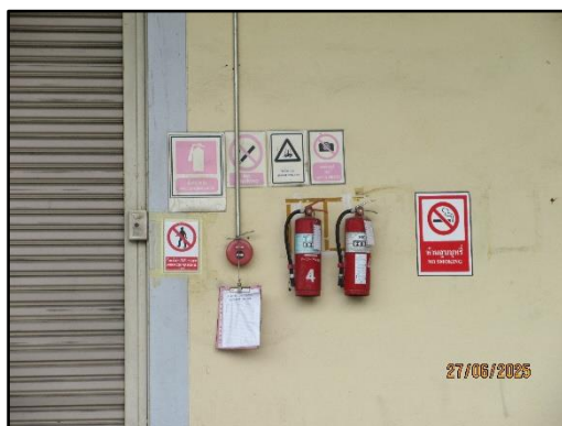
รูปที่ 38 ถังดับเพลิงเคมี บริเวณโกดังสินค้า
