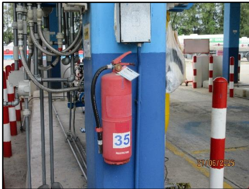
รูปที่ 41 ถังดับเพลิงเคมี บริเวณสถานีขนส่งถ่ายก๊าซ
