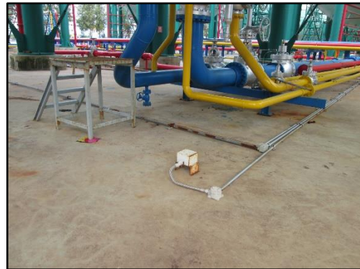
รูปที่ 46 เครื่องจับแก๊สรั่ว
