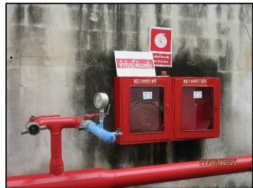
รูปที่ 43 ระบบดับเพลิงแบบ Fire Hose ภายในพื้นที่โครงการ
