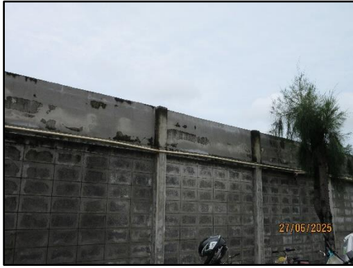
รูปที่ 2 กำแพงถาวรสูง 3 เมตร ที่มีวัสดุดูดซับเสียง ด้านติดกับโรงเรียนศิริวิทยา
