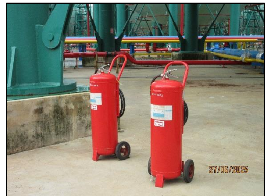
รูปที่ 39 ถังดับเพลิงเคมี บริเวณลานวางกองสินค้า
