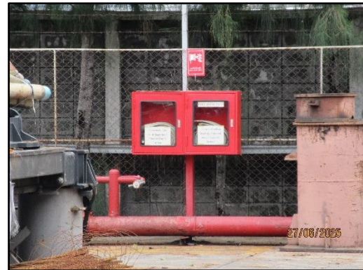
รูปที่ 43 (ต่อ) ระบบดับเพลิงแบบ Fire Hose ภายในพื้นที่โครงการ
