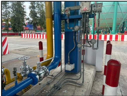
รูปที่ 46 เครื่องจับแก๊สรั่ว
