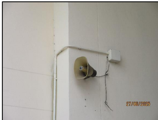
รูปที่ 34 สัญญาณแจ้งเหตุไฟไหม้
