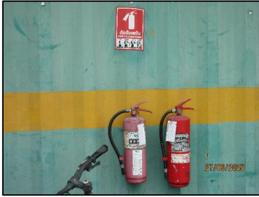
รูปที่ 39 ถังดับเพลิงเคมี บริเวณลานวางกองสินค้า
