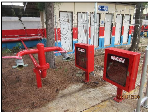
รูปที่ 43 ระบบดับเพลิงแบบ Fire Hose ภายในพื้นที่โครงการ
